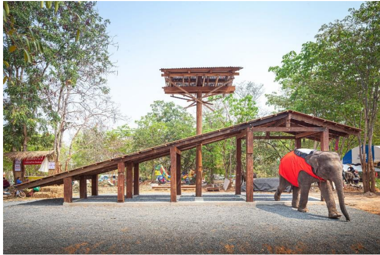
โครงสร้าง บ้านคน - บ้านช้าง
